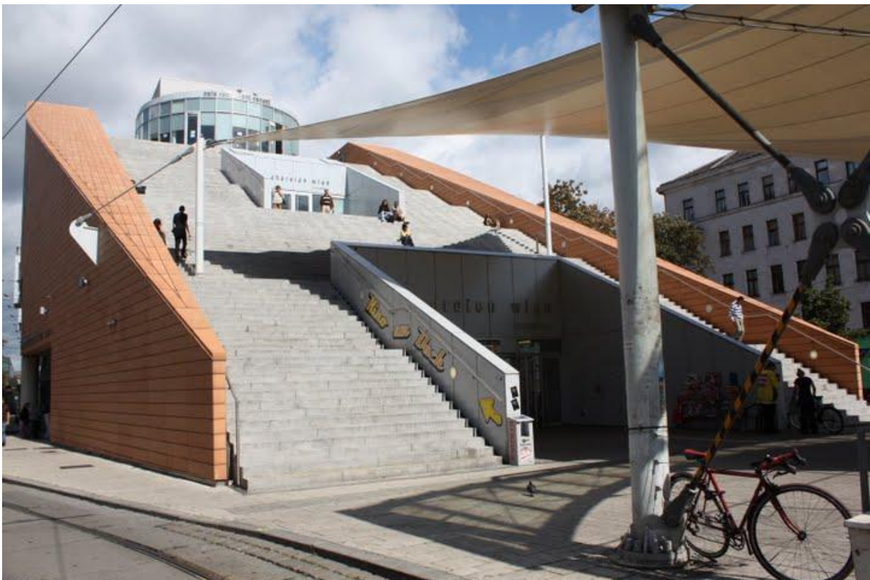
Eingang der Hauptbücherei der Stadt Wien
